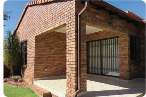
► Before: Existing Patio
